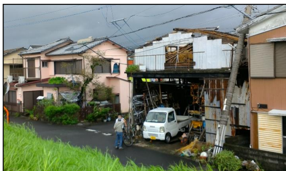
折損した電柱及び屋根が損壊した倉庫 (宮崎県延岡市) (9/22 撮影 気象庁職員)
