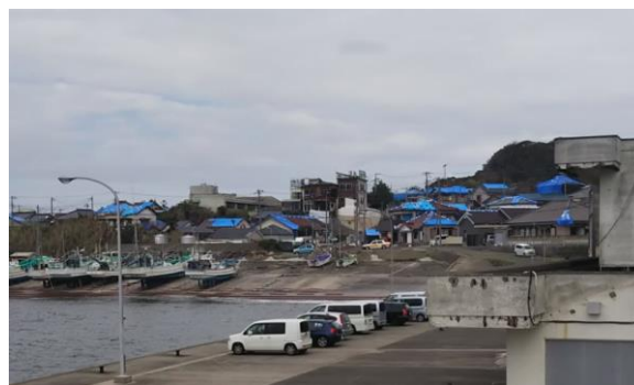
ブルーシートで屋根を保護する家屋 (9/23撮影 気象庁職員)
