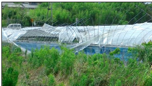
鋼管が変形した農業用ハウス (高知県安芸郡芸西村 6/28 撮影 気象台職員)
