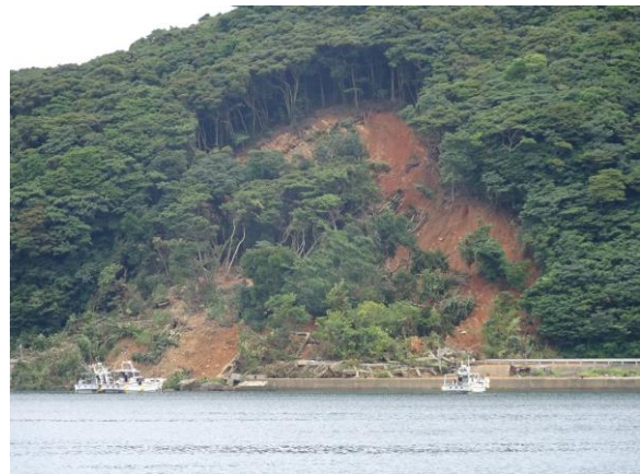
長崎県上五島町の土砂災害 (7/24 撮影 気象台職員)
