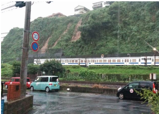
鹿児島県鹿児島市南鹿児島駅の土砂災害 (7/3 撮影 気象台職員)
