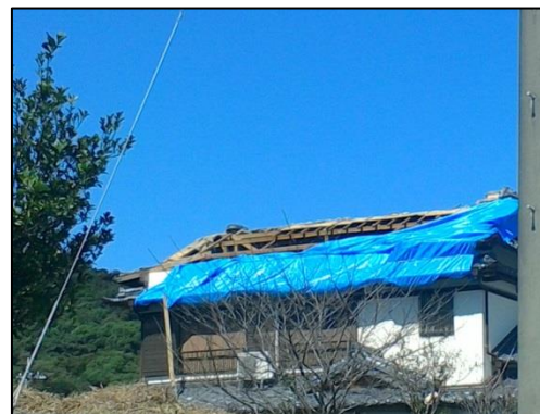
屋根の野地板が飛散した住家 (高知県高知市 10/1 気象台職員撮影)
