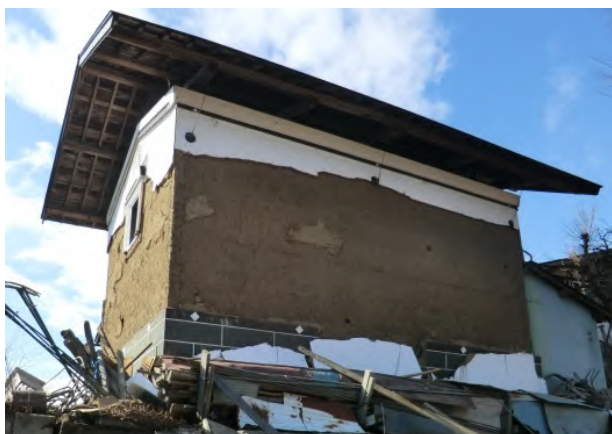
写真 26 納屋の壁の剥離（長野市鬼無里）
