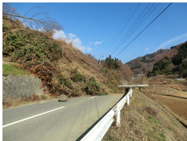
写真24 道路を塞いだ土砂崩れ (長野市戸隠豊岡)
