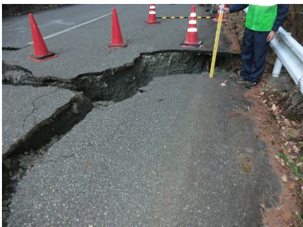
写真 16 路面の陥没
