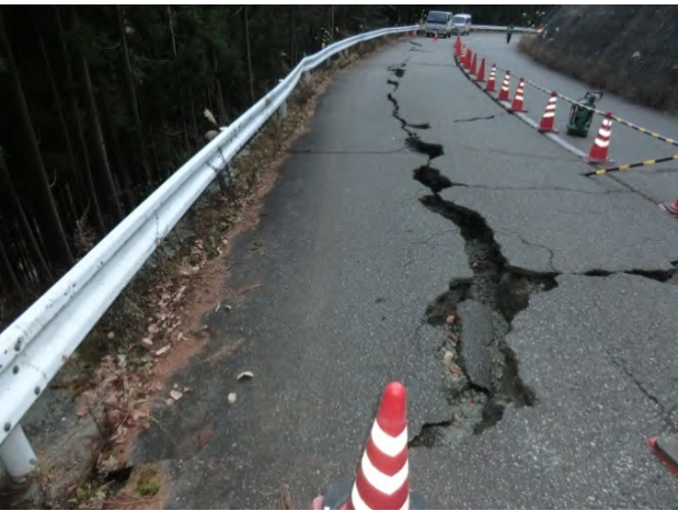
写真 15 路面の亀裂
