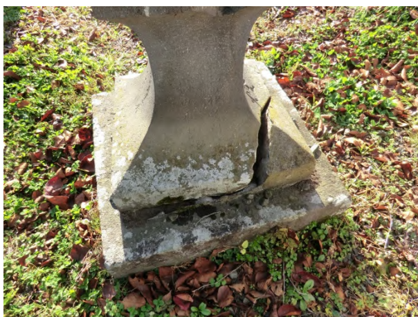
写真2 神社の石灯籠の亀裂（長野市戸隠豊岡）
