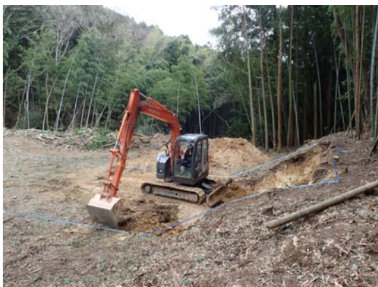
掘削時の様子
