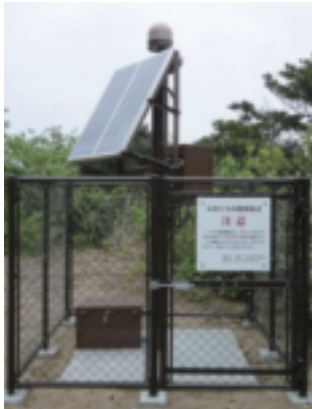
GNSS 観測装置
