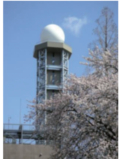
東京レーダーの外観。白いドームの中にパラボラアンテナが設置されています。
