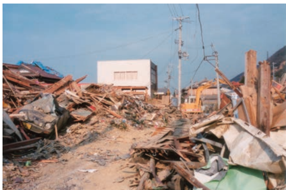
「平成7年（1995年）兵庫県南部地震」による被害
