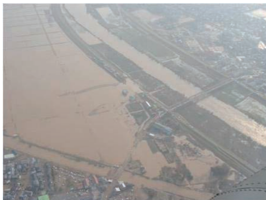
兵庫県豊岡市 円山川の破堤による洪水被害
