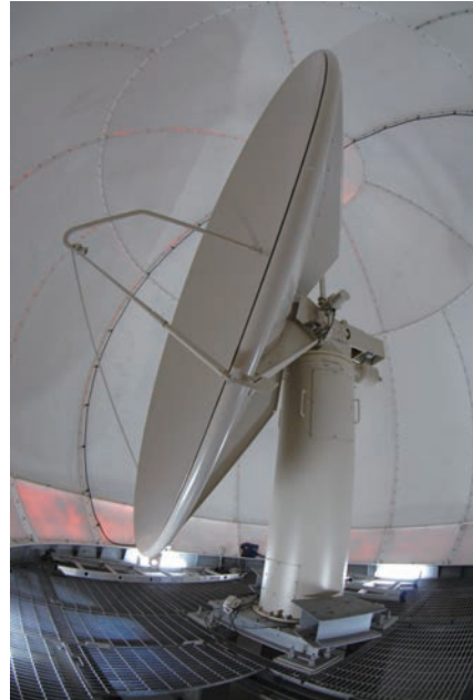
函館に設置されている気象レーダー（左）とアンテナ（右）。アンテナは丸いドームに覆われ、風雨などから保護されています。
