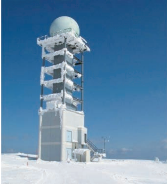
函館に設置されている気象レーダー（左）とアンテナ（右）。アンテナは丸いドームに覆われ、風雨などから保護されています。
