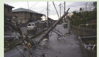
竜巻による被害
