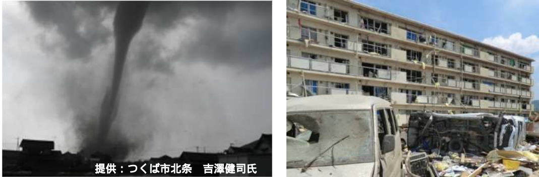
写真5：竜巻による被害(平成24年5月：茨城県つくば市)
