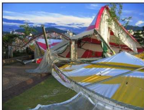
写真 6：ガストフロントによる被害
