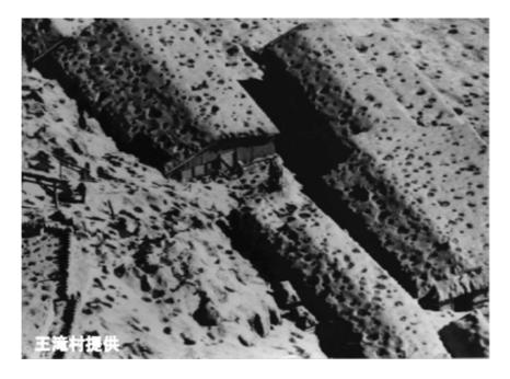
図 2 5 御嶽山 1979 年の噴火での噴石による被害 (1979 年 10 月 30 日撮影 王滝村提供) 剣ヶ峰山頂の神社及び山小屋で噴石による被害が発生した。
