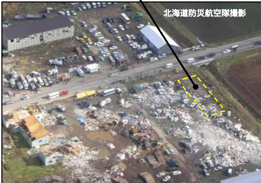
写真2 工事現場周辺の上空写真(□は飛散した工事事務所跡)
