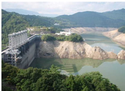
早明浦ダム2008年ダム湖の水位低下時 [写真提供: 吉野川水系水利利用連絡協議会] 2008年は7月以降太平洋高気圧に覆われて晴れた日が多く、降水量が少なくなった
