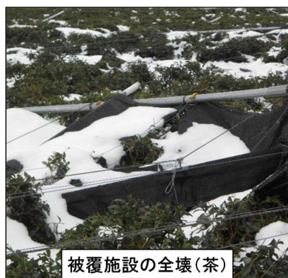
第 4.5.4 図 積雪による被害例（近畿農政局提供） 積雪により、施設が倒壊しています。
