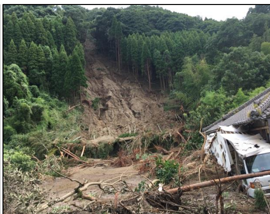
垂水市二川地区の山崩れ現場 (提供：垂水市)
