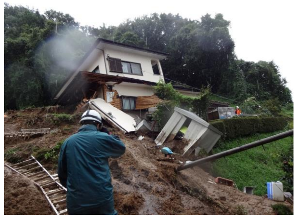
栃木県鹿沼市の土砂災害 (提供：栃木県県土整備部)
