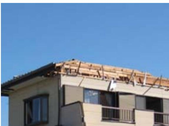
屋根の一部が飛散した住家 (埼玉県 熊谷市)
