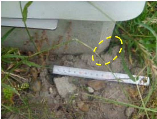
震度計基礎台西側と地面との隙間。
