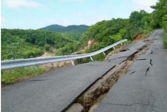
市道馬場駒の湯線の路面崩壊。
