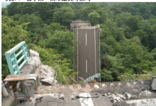
祭時大橋が大規模な斜面崩壊によって地盤とともに橋脚が移動して崩落した。
