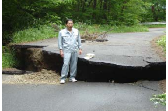
市道馬場駒の湯線。路面に段差ができた。
