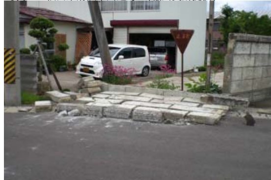
工場のブロック塀の一部損壊。
