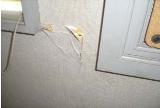
自動車整備工場の内壁にひび割れ。
