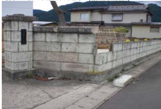
工場のブロック塀の一部損壊。
