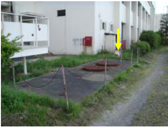
西方向から見る震度計（宮城県整備） （矢印の場所）
