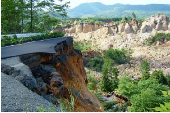
荒砥沢ダム周辺の大規模崩壊。
