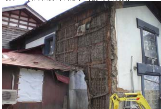
土蔵の内壁・外壁剥離、亀裂。
