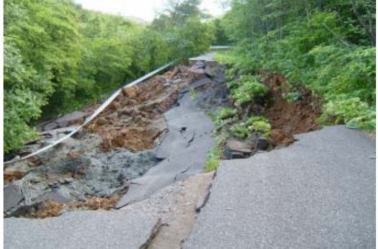
市道馬場駒の湯線の路面崩壊。
