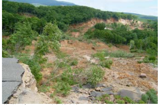
荒砥沢ダム周辺の大規模崩壊。
