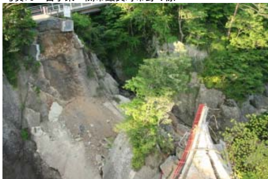
矢櫃ダム近くの旧昇仙橋が落橋。
