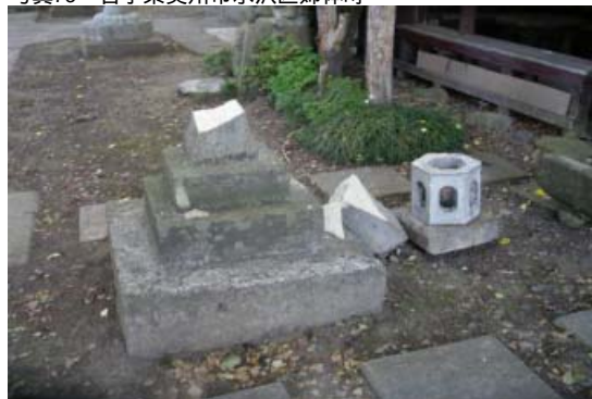
古い灯籠の倒壊。
