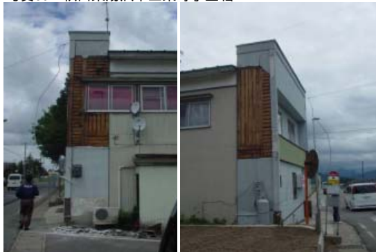
飲食店の外壁のモルタル部分(1.2×3.6m)のみ破損落下(両側からの写真)。
