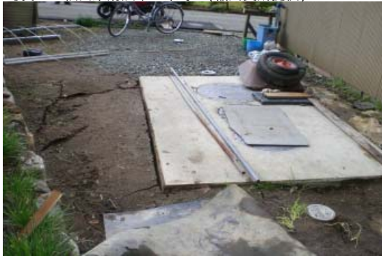
浄化槽周辺の地盤沈下。
