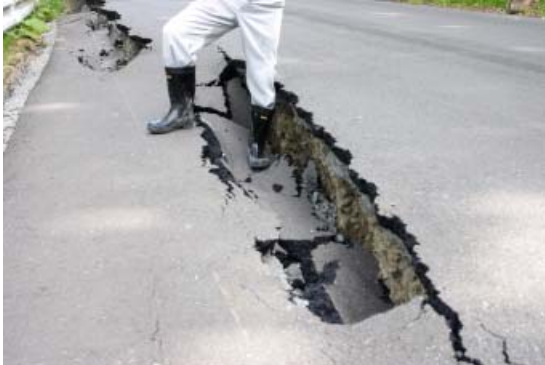
栗原市栗駒耕英地区への市道馬場駒の湯線が通る栗駒沼倉地区の斜面で幅50センチ、長さ50メートル程度の亀裂2本。
