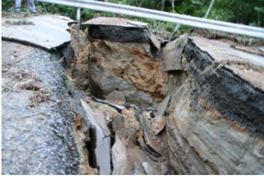
荒砥沢地区の路面崩壊。
