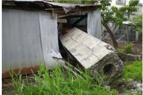
工場の煙突の倒壊。
