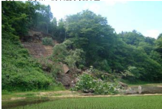
一関市巖美町楓木立(はのきだち)のがけ崩れ。崩落した高さは26m。
