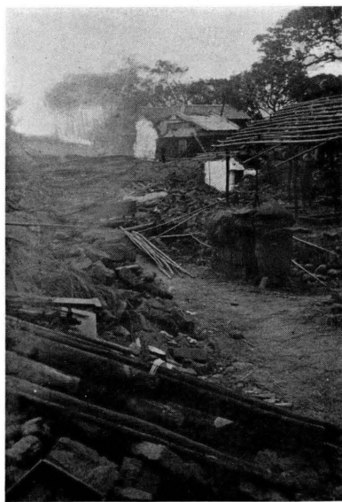
銅鑼庄老鷄隆、土角家屋は全然崩潰したが、向う側に見える木造家屋は修理すれば再び使用出来る
