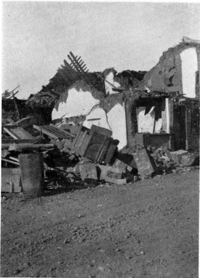
内埔庄后里、(68) 后里驛の北西、斷層線上の土角家屋の崩潰、(69) 后里驛前、 (70) 十字路附近
