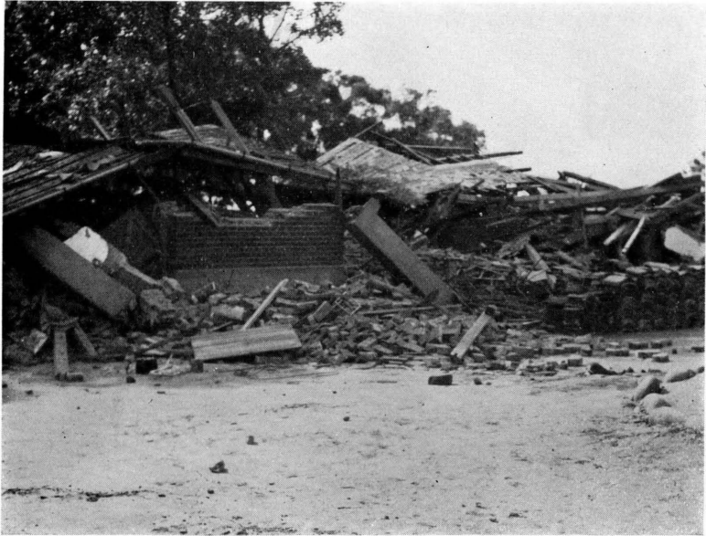
内埔庄屯子脚、公學校、(61)向う側は木造教員住宅、前方全く崩潰してゐるのは土角家屋、(62) 斷層線上の校舍全潰
