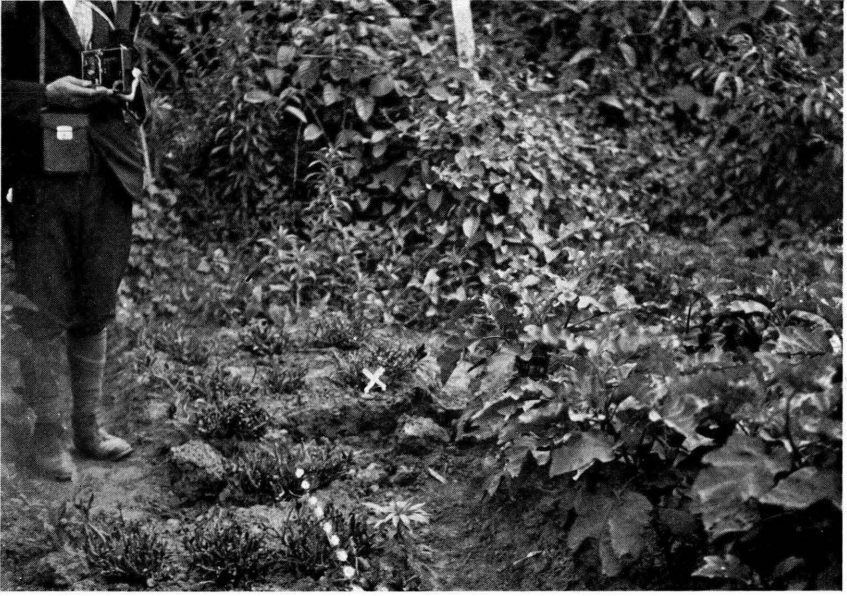
内埔庄屯子脚公學校北東方の畑中に於けるうねの喰違ひ、北側は約 60 糎北東方に移動す
