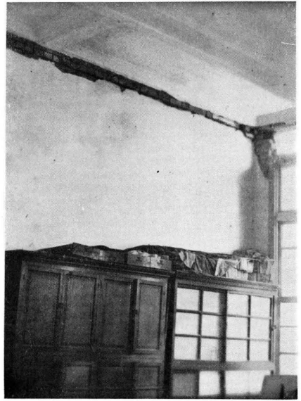
沙鹿庄役場 (46) 外観、(47) 一部、(48) 二階の内部、煉瓦造、二階の窓の上及下の線を境として切斷されてゐる
