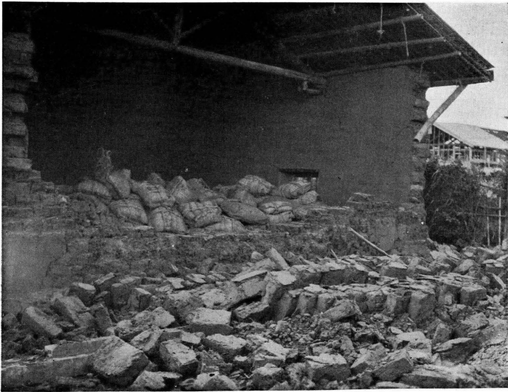
(54)、(55)、(56)、内埔庄下月眉、土角家屋破壊の状、壁が崩れ落ちたのが殆んど一つ一つの土角の集積となつてゐる
