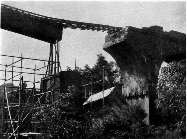
(94)、(95)、十六份驛と大安驛の中間、橋臺折損、大破せる様を示す
