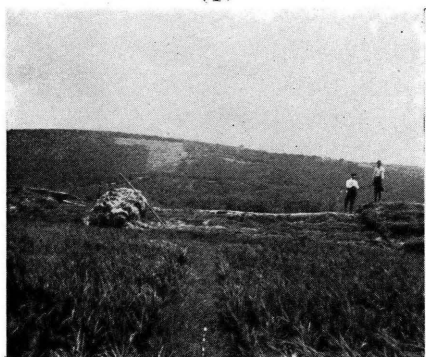
清水街と沙鹿庄との中間、鐵道線路 寄り堤防上の龜裂
