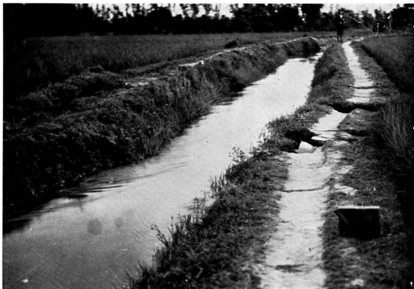
内埔庄舊社と屯子脚の中間、斷層線の北側は東北東向きに 60 糎餘移動し幾分沈下す
