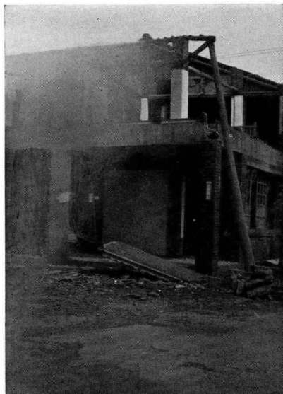
後龍驛前、煉瓦柱の家屋の破損
