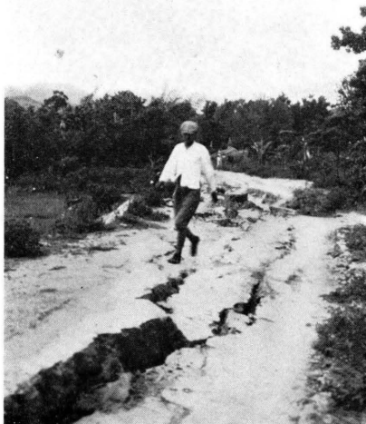
(34)、(35) 銅鑼庄銅鑼と老鷄隆との中間に於ける崖崩と道路の龜裂
