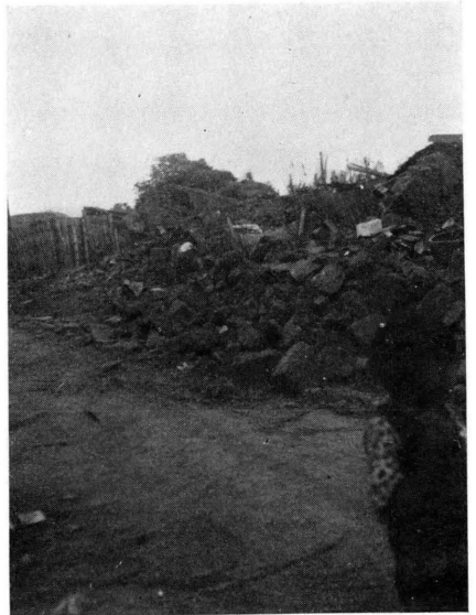
内埔庄后里、(68) 后里驛の北西、斷層線上の土角家屋の崩潰、(69) 后里驛前、 (70) 十字路附近
