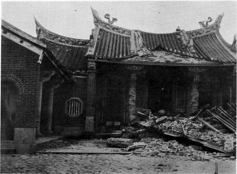
公館庄鶴子岡、廟の前面、屋根飾りの破損
