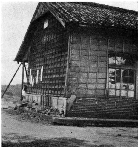
銅鑼庄老鷄隆、公學校木造校舎の被損
