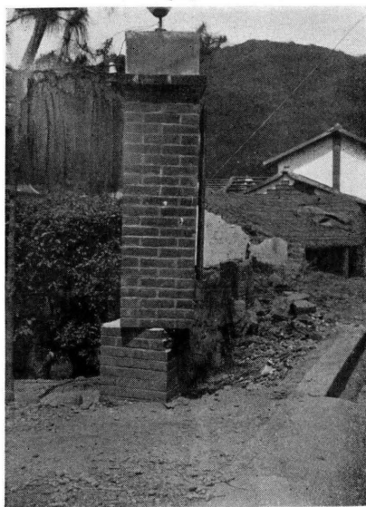
大湖庄、煉瓦門柱が切斷して時針 向きに回轉したもの
