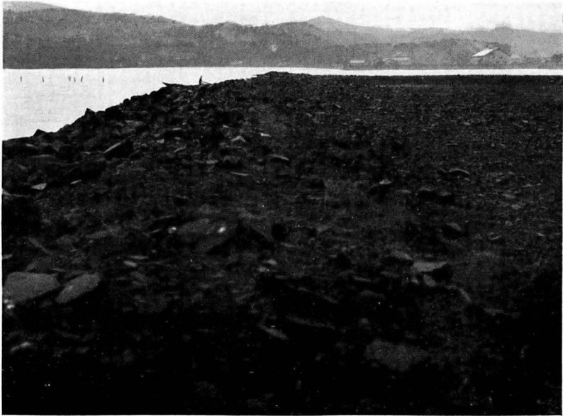
十七、志津川町 堤防の石垣決壊し埋立地の上に飛散す
