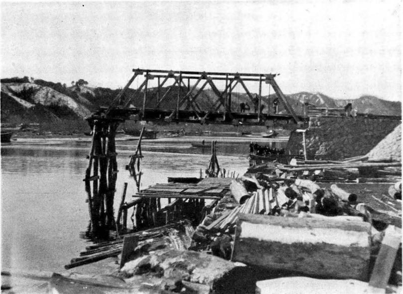
六十二、宮古町 津浪に押し上げられた船のために破損した宮古橋
