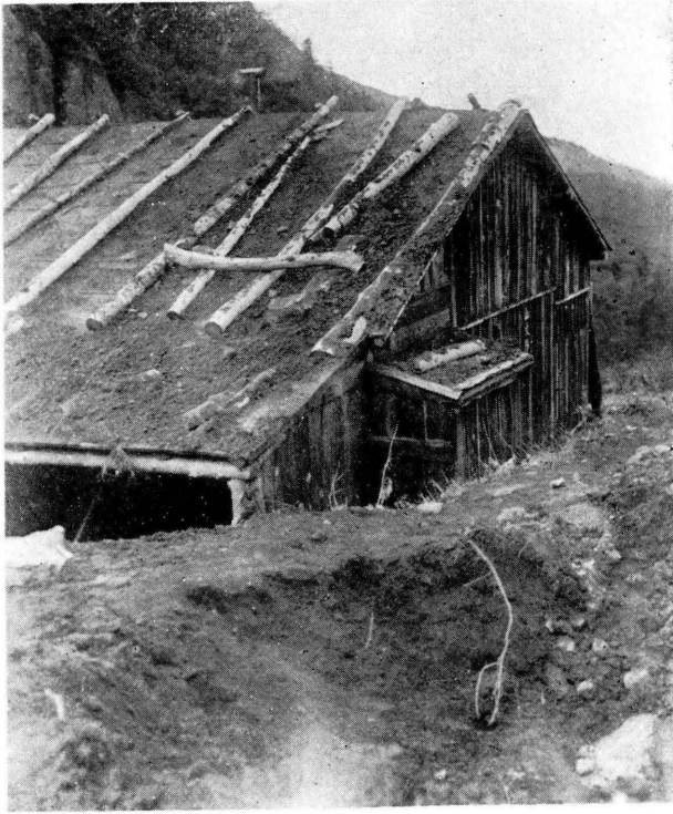
第六圖 噴出された岩石により土砂を浴せられた 峯の小屋と地面に穿たれた大穴
