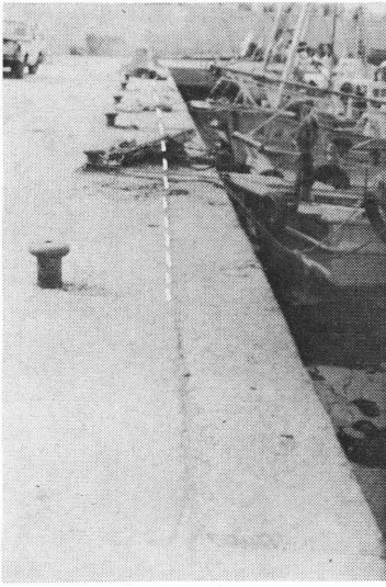
Photo. 7. 横浜町漁港岩壁 破線部分で「ずれ」現象が起る。
