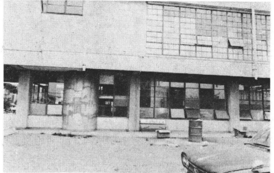
Photo. 17. 三沢市公民館 窓ガラスが一部破損
