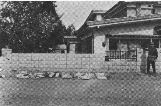
Photo. 9. 三沢市山中 ブロック塀の一部落下損傷
