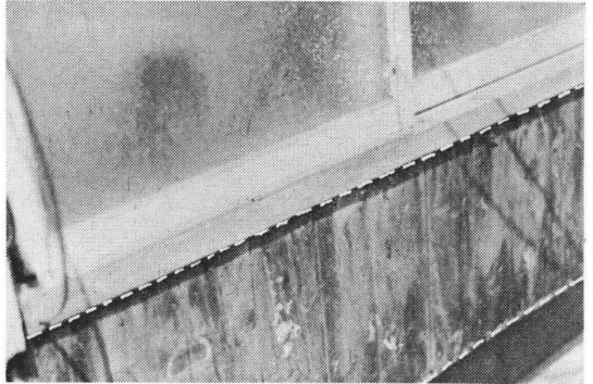
Photo. 5. 六ヶ所村尾駮警察駐在所 破線の部分 でモルタル剝離
