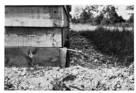
写真 4. 教員住宅の土台ずれ
