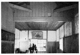
写真 3. 同小学校廊下はりのひび割れ(中央のはりに 亀裂がみえる)
