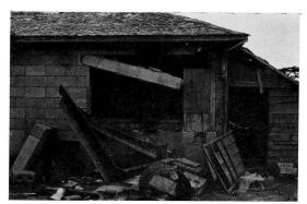
写真 8. びるわ開拓地 神氏宅のブロック崩壊 (札管 横山技官撮影)
