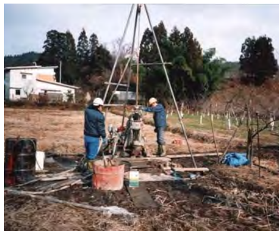
横手盆地東縁断層帯のボーリング調査（秋田県） 写真提供：秋田県
