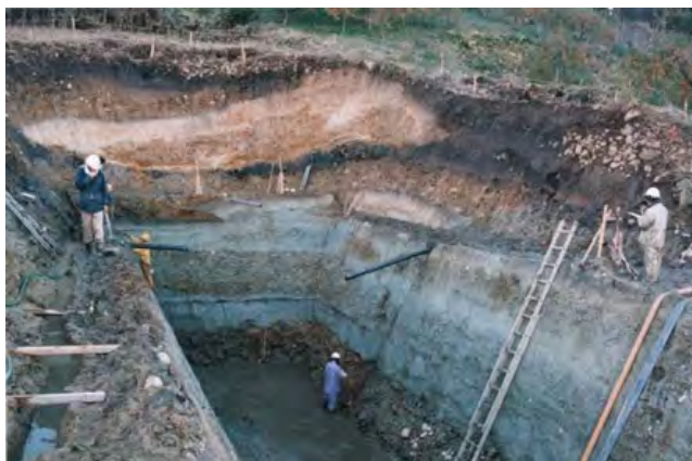
福島盆地西縁断層帯のトレンチ調査 断層面が直接確認された（福島市大笹生） 写真提供：福島県
