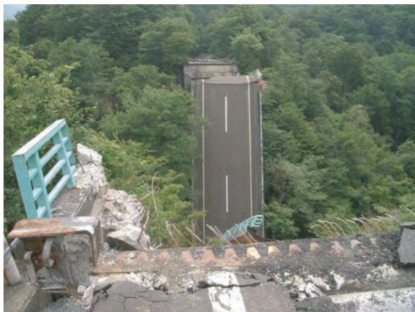
橋脚の崩落 (岩手県一関市の祭時（まつるべ）大橋)
