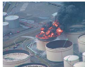
2003年十勝沖地震による長周期地震動の影響で発生した苫小牧のタンク火災 A tank fire broke out in Tomakomai due to the long-period ground motion of the Tokachi-oki Earthquake of 2003.
